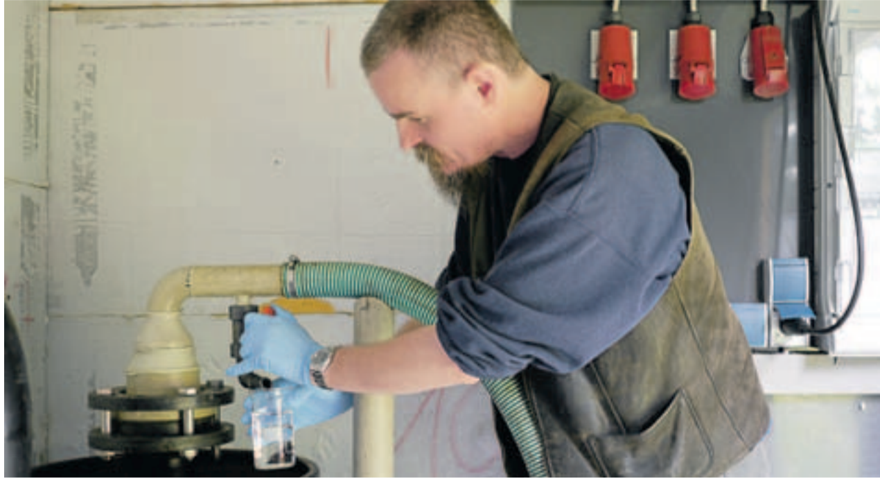
Das aus dem Boden gepumpte verseuchte Wasser wird in einer Kaskade von drei Fässern mit Aktivkohle filtriert. Axel Olbinsky, Projektleiter der Sanierung der Merkel'schen Grube, nimmt eine Probe. Fotos (2): Westermann
